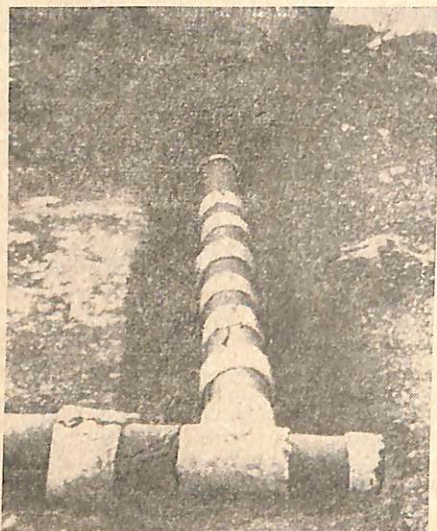
Рис. 1. Самофракия. Отрезок водопровода
