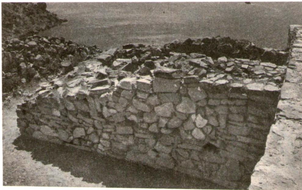
Рис. 3. Юго-восточная башня. Вид с севера
